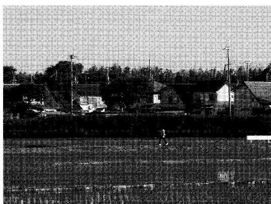
写真6 霞堤開口部での開発（愛知川），住宅地の手前に控え堤，奥に本堤がある。（撮影：辻光浩，2010）
