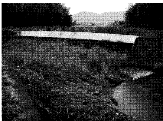
写真5 不連続堤防の閉め切り（祖父川），対岸には集落があり，超過洪水時に集落側に溢水・破堤することを回避する機能を有していた。（撮影：岸本裕美子，2009）
